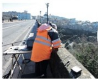
Roberto Di Felice, insieme ai dirigenti comunali dell'Ufficio Tecnico e della Polizia Locale, per verificare la situazione. La polizia locale di Ariccia sta vigilando sul rispetto dell'ordinanza di chiusura e
